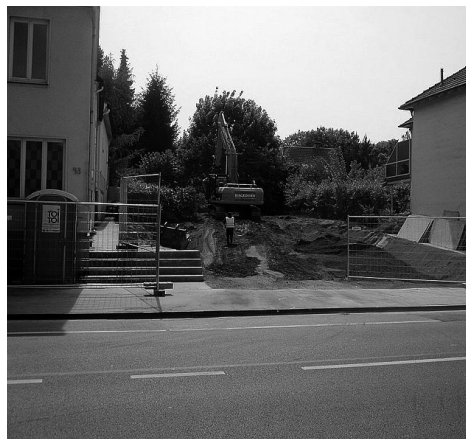
Bauen, wo noch Platz ist: Neubau an der Stapenhorststraße 95.
