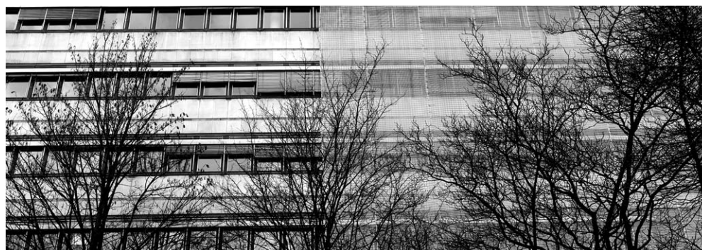
Die Fassade der neuen FH (Foto oben) ist fertig, die der alten auch: Netze schützen gegen die Gefahr von herabstürzenden Platten.
